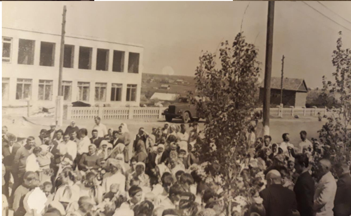
Будівництво нової школи
